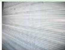
机组翅片清洗后
